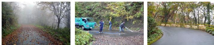
この時期のラリーでオフィシャルが一番頭を悩ますのは、林道に積もった落ち葉の掃除だ。例年たけぼうぎによる人海戦術でコースを埋め尽くす落ち葉の掃除をしていたが、一昨年よりエンジンコンプレッサーによって落ち葉を吹き飛ばしていく方法に切り替え効率は上がった。しかしそれでも林道1本に1日かかってしまう。
